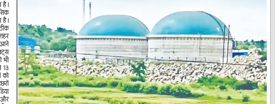
● जेबीआर टेक्नोलॉजी से किया गया है हाईक्वालिटी एसटीपी का निर्माण
