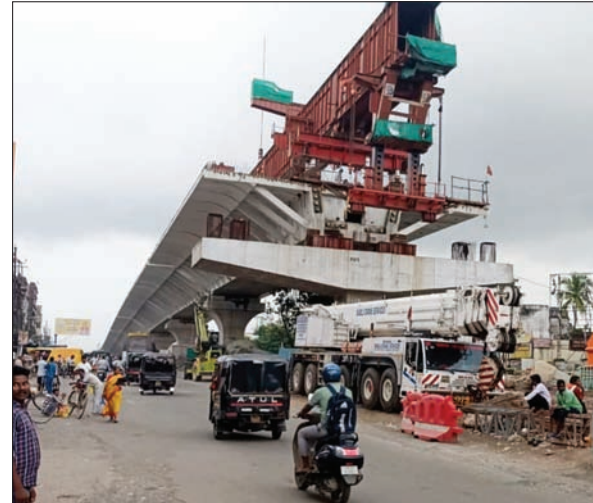
फ्लाईओवर का चल रहा निर्माण कार्य
