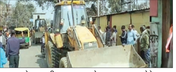
टाटानगर स्टेशन पर अतिक्रमण हटाता बुलडोजर
