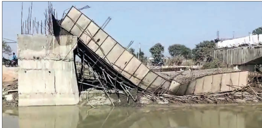
निर्माण के दौरान ढलाई पुल
